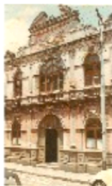
Detalle de la fachada y entrada principal
