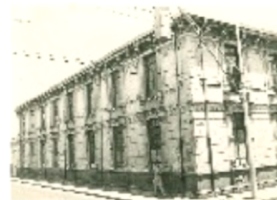
Detalle de la fachada, vista desde el ángulo sur
