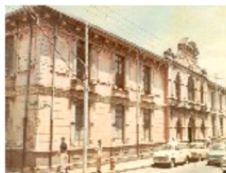
Detalle de la fachada, vista desde el ángulo sur este
